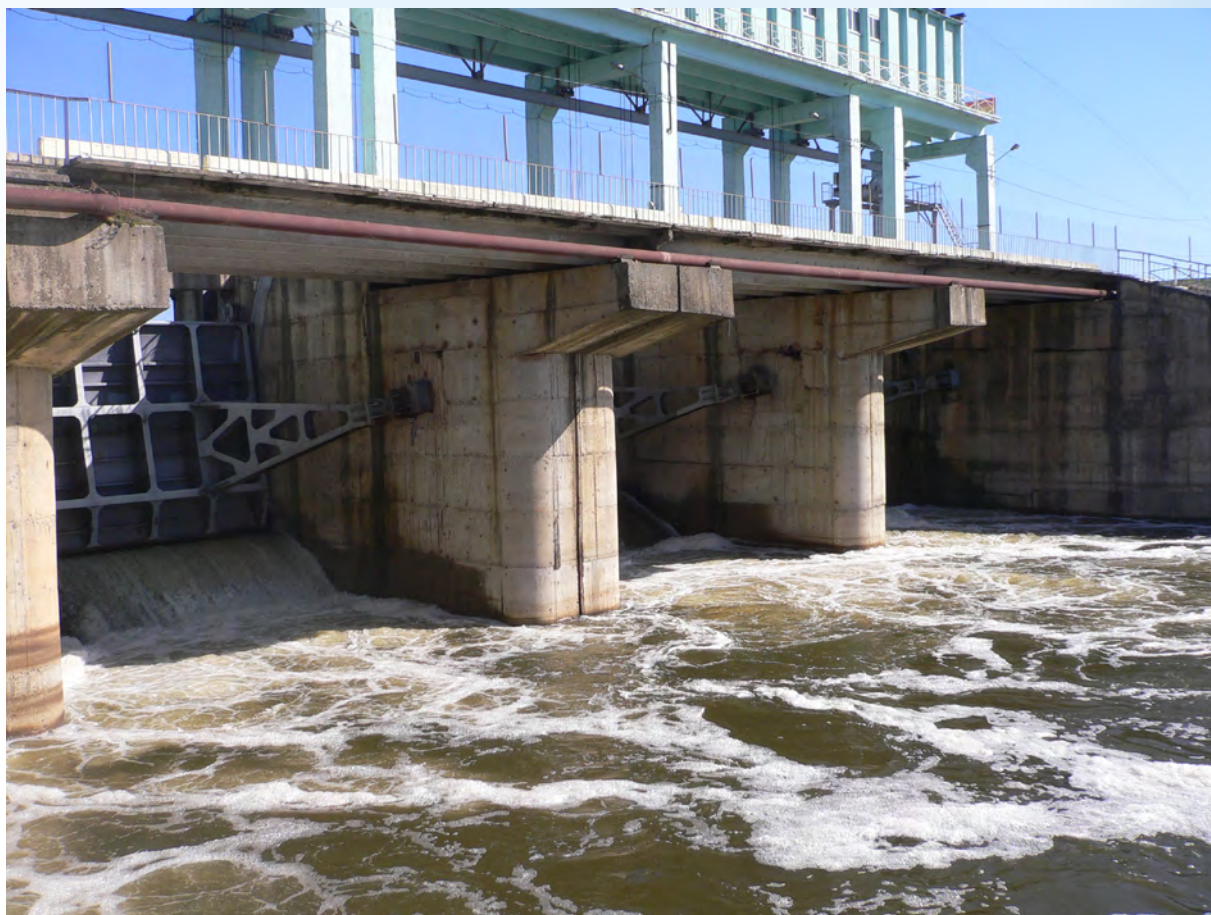
Рис. 15.14. Гидроузел Курского водохранилища
