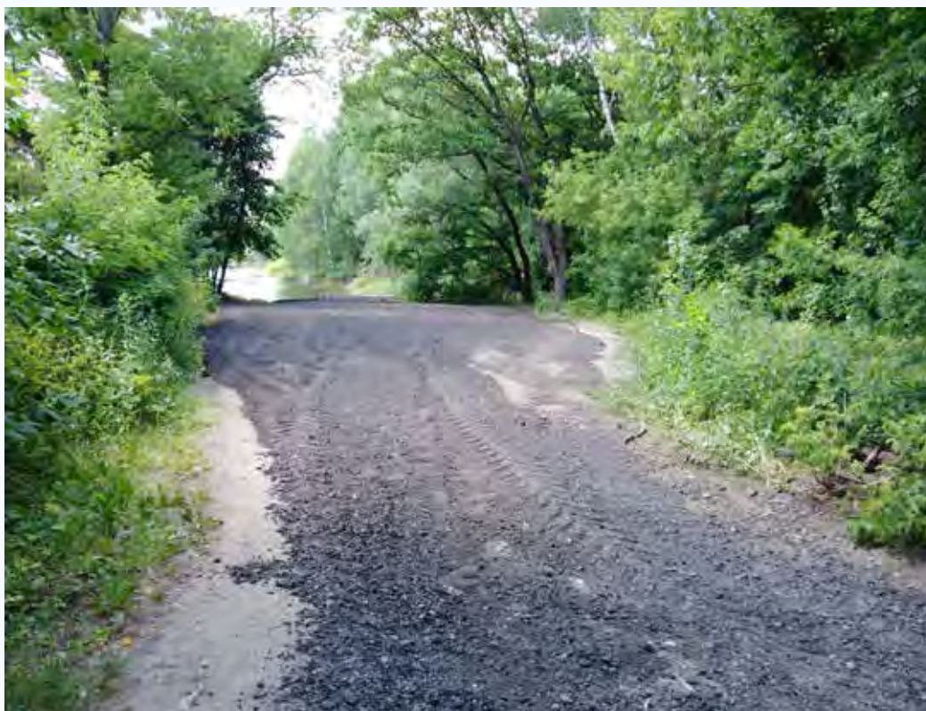
Рис. 12.4. Подсыпка асфальтовой крошки
